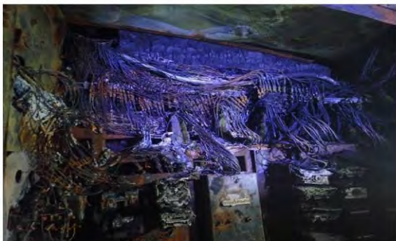
Foto nr.5 - Bloc de aparate cu cablaj ars în partea superioară.
