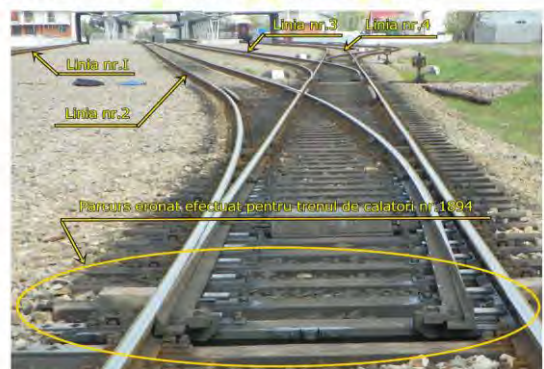
Fig.2 Poziția acelor macazului schimbătorului de cale nr.25
