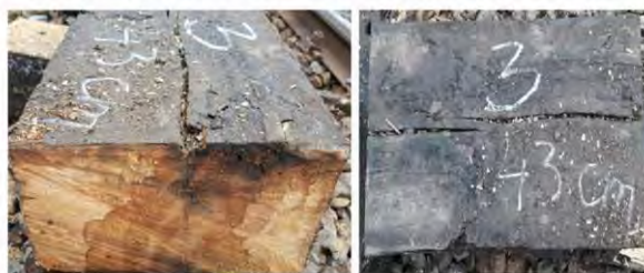
Imagina 12 - fragmentul 3 - crăpături dinspre fața superioară spre interior, formare secțiuni de rupere
