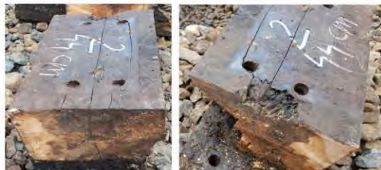
Imagina 11 - fragmentul 2 - crăpături pe fața superioară și crăpătură în adâncime pe lungimea chitucului, lemn putred pe fața superioară și în interior
