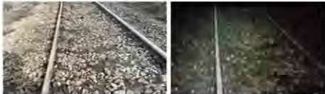
Imagina 5 - Prisma de piatră spartă la data producerii deraierei (zone cu piatră spartă care împiedică vizualizarea stării tehnice a traverselor în zona de fixare a plăcilor metalice)
