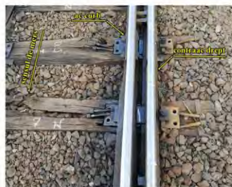
Figura 8 - starea tehnică a traverselor nr.,7"-„8"
