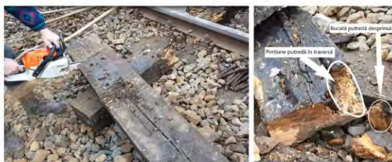
Imagina 9 - Traversa înainte de secționare; Porțiuni putrede care se desprindeau la manipulare;
