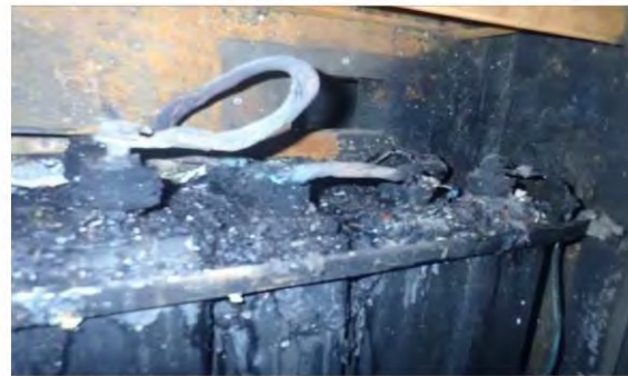
Foto nr.3 - Baterii de acumulatori cu depuneri de material ars.
