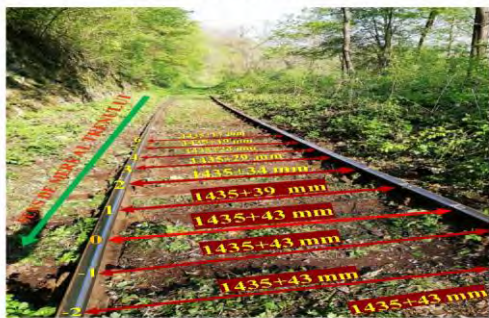
Fotografia nr.2: Zona producerii deratării. Valorile ecartamentului în picheții -3/6
