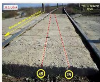
Foto nr.2 – Urmele produse de roțile 4R și 3R ale boghiului deraiat după escaladarea dalilor de beton interioare ale trecerii la nivel
