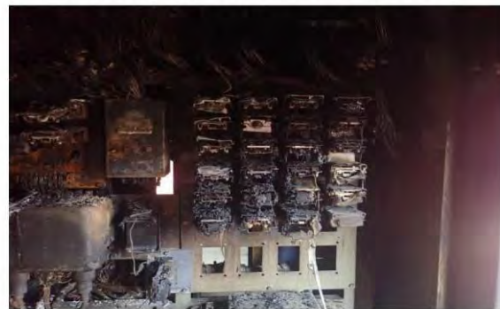
Foto nr.4 - Bloc de aparate cu echipament distrus.
