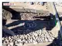
Foto nr.6 – Traversa T 0 în cale
