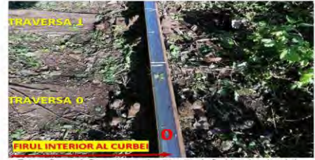
Fotografia nr. 4: Sarea traverselor T0 și T1 - la firul interior al curbei
