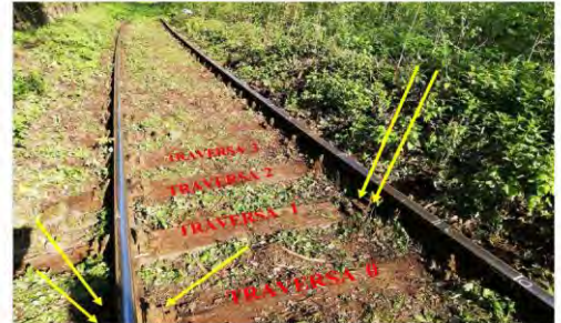
Fotografia nr. 5: Sarea tehnică a traverselor T0, T1, T2, T2 și T3 la firul interior al curbei
