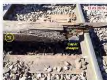
Foto nr.10 - Traversa T 5
