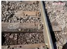
Foto nr.9 - Traversa T 5 în cale
