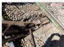
Foto nr.11 – Traversa TL 3 (putredă, ruptă la scoaterea din cale)
