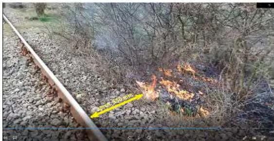
Foto nr.12 – Incendiu de vegetație din zona căii ferate
