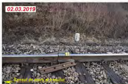
Foto nr.6 – Joanta la care s-a produs deraierea celorlalte două osii ale boghiului locomotivei
