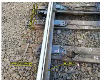
Figura 6 – starea tehnică a traverselor nr.,0"-„2"
