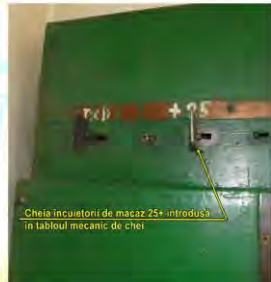
Fig. 6 Partea superioară a tabloului mecanic de chei de la cabina nr.3
