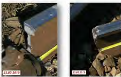
Foto nr.9 #13 – Secțiuni de rupere a șinei din cale
