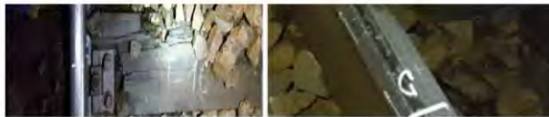
Imagina 6 - Punctul C (urma de cădere a roții din dreapta între firele căii este marcat pe șina din dreapta în locul în care șina sprijină pe traversa T-16)
