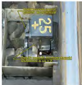
Fig. 5 Încuierii de macaz 25+ a schimbătorului de cale nr.25
