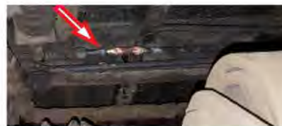
Conducta de aer prezenta dop de gheață, termoizolația era lipsă
