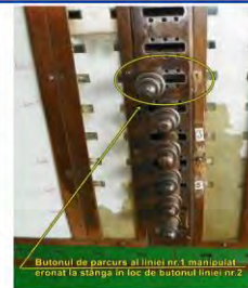
Fig. 8 Tabloul mecanic de chei de la cabina nr.3
