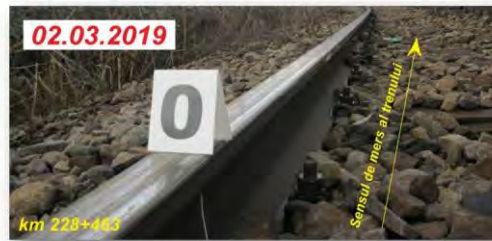
Foto nr. 4 – Prima urmă de deraiere. Punctul de cădere a roții din stânga primei osii în sensul de mers, între firele de șină ale căii
