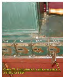
Fig. 9 Cutia mecanică a blocului SBW partea cu încuierii chei de la cabina nr.3
