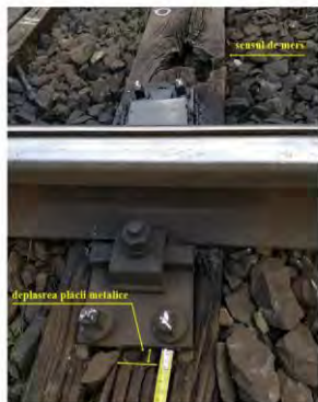
Figura 5- deplasarea alunecătorului în lungul traversei sub acțiunea sarcinilor dinamice transmise de materialul rulant
