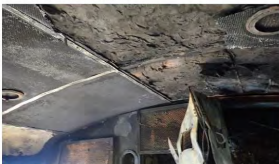
Foto nr.6 - Plăci tavan deformate și degradate.
