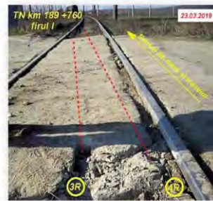
Foto nr.1 – Urmele produse de roțile 3R și 4R ale boghiului deraiat după escaladarea dalelor de beton interioare ale trecerii la nivel
