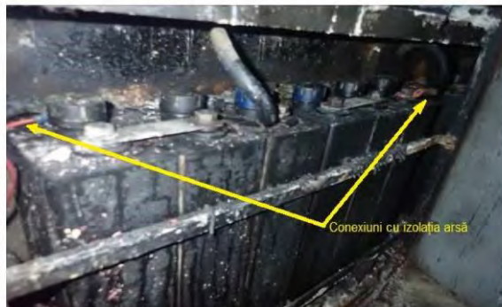
Foto nr.2 - Etajul superior al bateriilor de acumulatori
