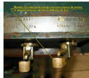
Fig. 10 Cutia mecanică a blocului SBW, partea cu manete de la cabina nr.3
